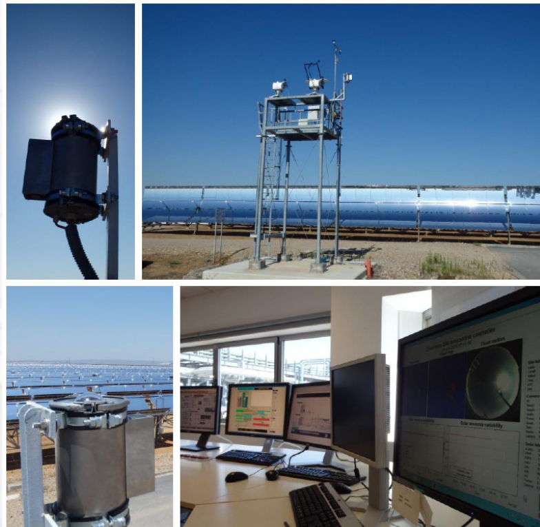
Figure 3 : Aperçu du système installé à Palma del Rio (centrale de Palma del Rio II, d'une puissance de 50 MW).
