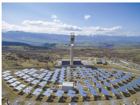
Figure 3 : Centrale solaire à tour solaire de Thémis et son champ d'héliostats (dont plusieurs endommagés par la grêle du 15 juin 2017, ici avant le remplacement des miroirs cassés).
