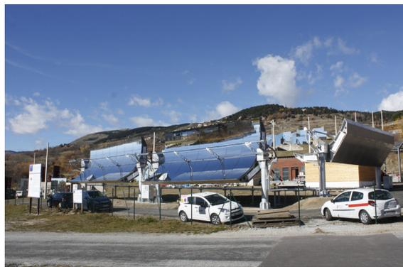
Figure 4 : Cylindro-parabolique MicroSol'R : les concentrateurs au premier plan, le bâtiment machinerie et la salle de contrôle partagée avec l'EuroDish derrière.
