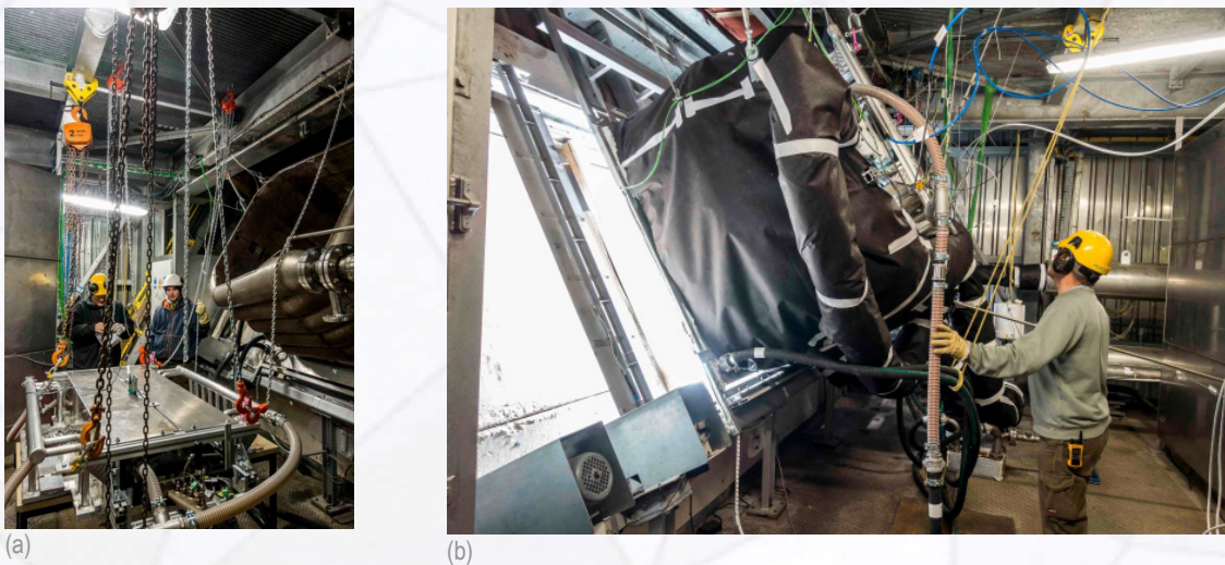
Figure 9 : (a) Préparation des palans pour la mise en place de l'ensemble module / support / panneaux réfrigérés en fond de cavité ; (b) Ensemble du volume expérimental pendant les expérimentations
