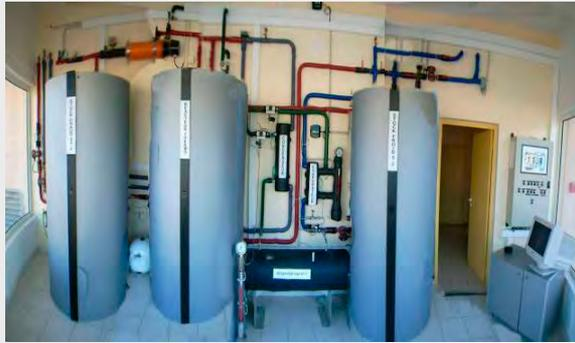
Figure 3a : Procédé thermochimique  $\text{BaCl}_2/\text{NH}_3$  couplé à 20m<sup>2</sup> de capteurs solaires thermiques plans pour le rafraîchissement solaire.
