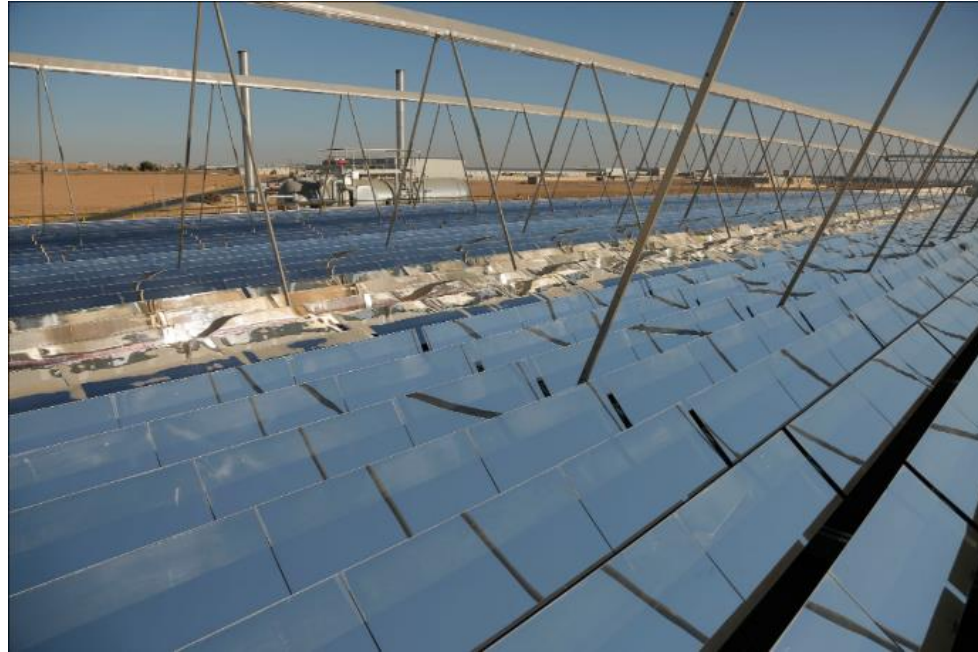
Fabrique de tabac, Jordanie. 1254 m 2 Fresnel linéaire. Vapeur, 225°C, 25 bars, 705 kW th
